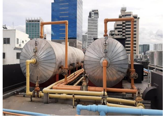
รูปที่ 8 ถังเก็บน้ำสำรองของโครงการ
