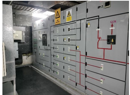
รูปที่ 10 ตู้ควบคุมระบบไฟฟ้า
